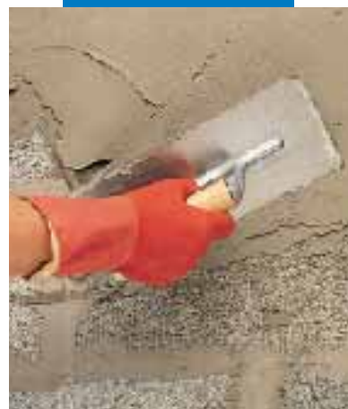
Aplicação de Idrosilex Pronto à espátula
