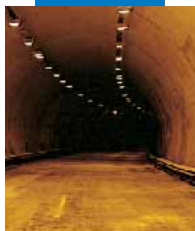
Aplicação por projecção de Idrosilex Pronto branco num túnel de uma auto-estrada
