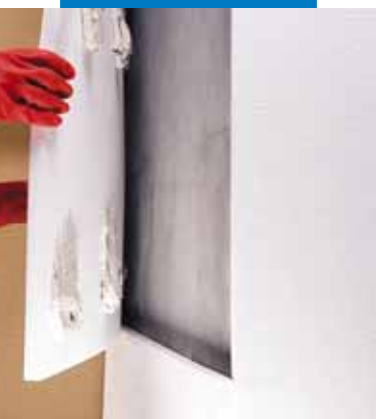
Colagem por pontos de painéis de material isolante
