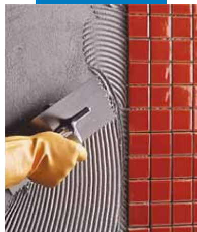
Aplicação de revestimento de mosaico cerâmico
