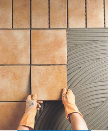
Assentamento de klinker no exterior
