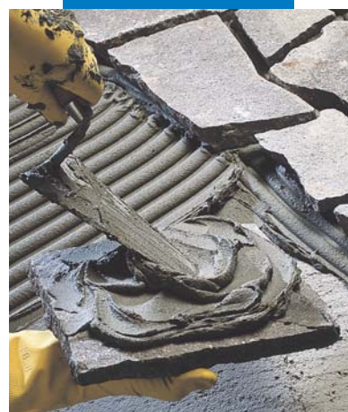
Assentamento de pedra rachada no exterior com ou sem barramento segundo a espessura
