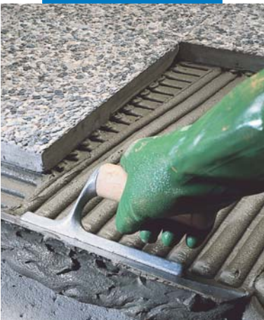
Assentamento de mármore em grés em relevo no exterior
