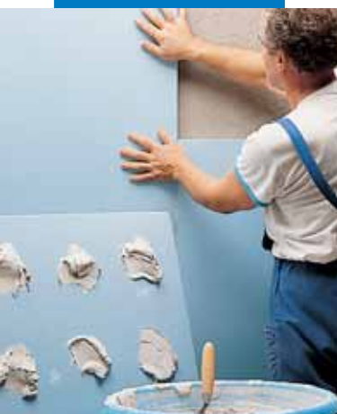
Assentamento de painéis de poliestireno com Keraflex branco
