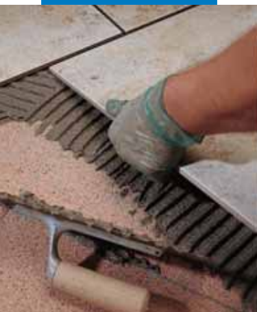
Assentamento de revestimento em monocozedura sobre mosaico hidráulico preexistente
